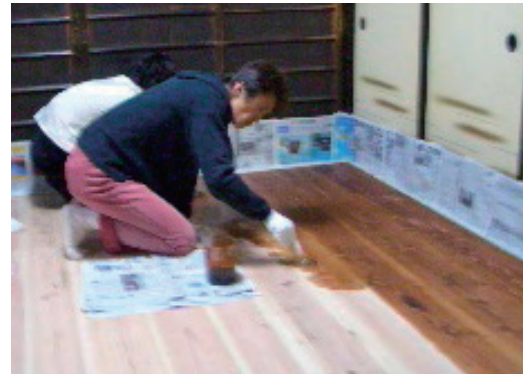
写真3 杉板フローリングに「MRⅢ：雅」を塗装 現場で塗装できるのが「MRⅢ：雅」の特徴。現場の温度湿度条件に応じて LTH、NOA を使用する。
